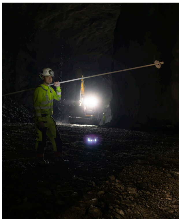
Johan bär med lätthet en PC-Bult R27/12 inför installation.
